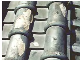
▲凍害によって破損した瓦
