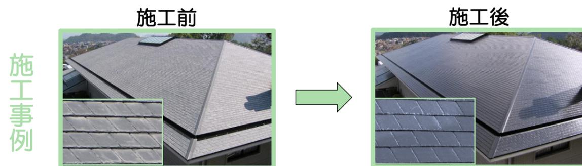
下記の様な屋根材に塗り替えできます。 ※乾式コンクリート瓦・陶器瓦・いぶし瓦にはこの商品では塗り替えできません。
