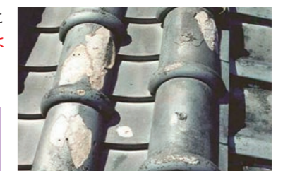
▲凍害によって破損した瓦
