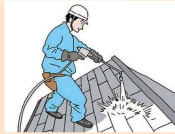
脆弱な旧塗膜、工場塗膜、汚れ等は除去してください。金属で錆がある場合は錆を除去してください(2種ケレン\*程度)。前回塗装時の塗膜が残る場合は、塗料シンナーで溶解試験をおこなってください。基材によって詳細が異なりますので、右記の内容を参考に調整してください。
