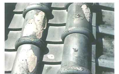
▲凍害によって破損した瓦
