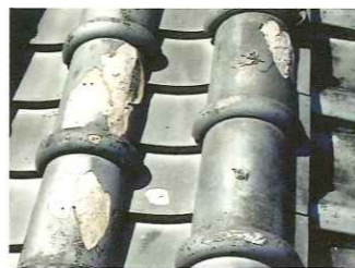
▲凍害によって破損した瓦
